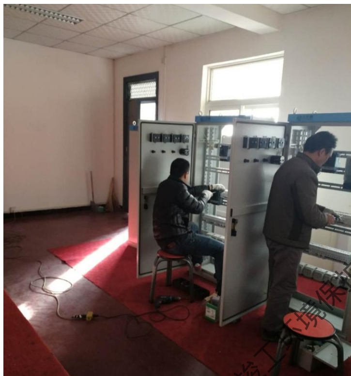
图 3-13 手工组装操作图
