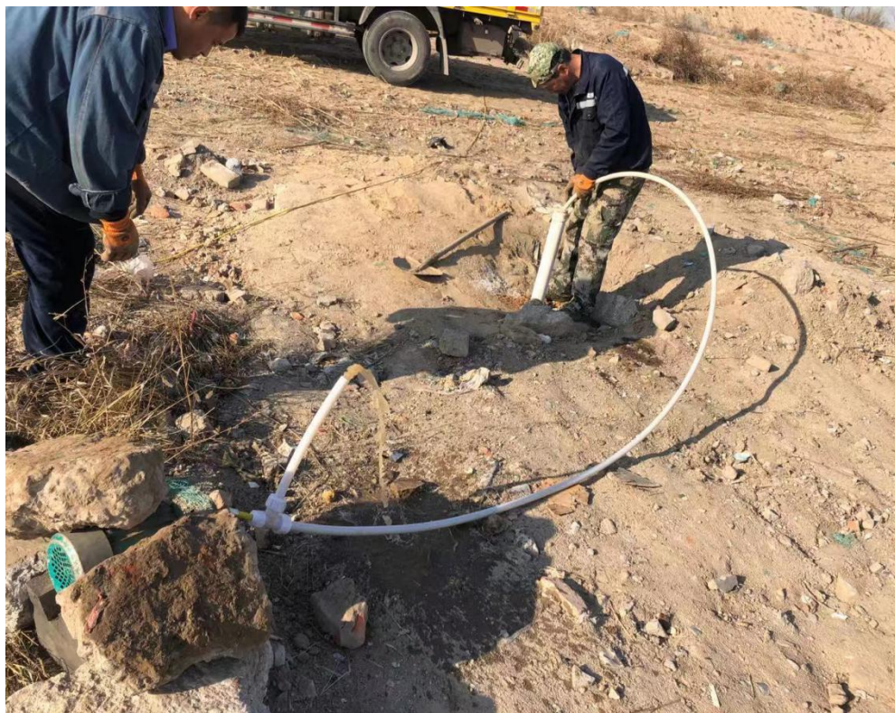
图 4.1-6 现场洗井照片
