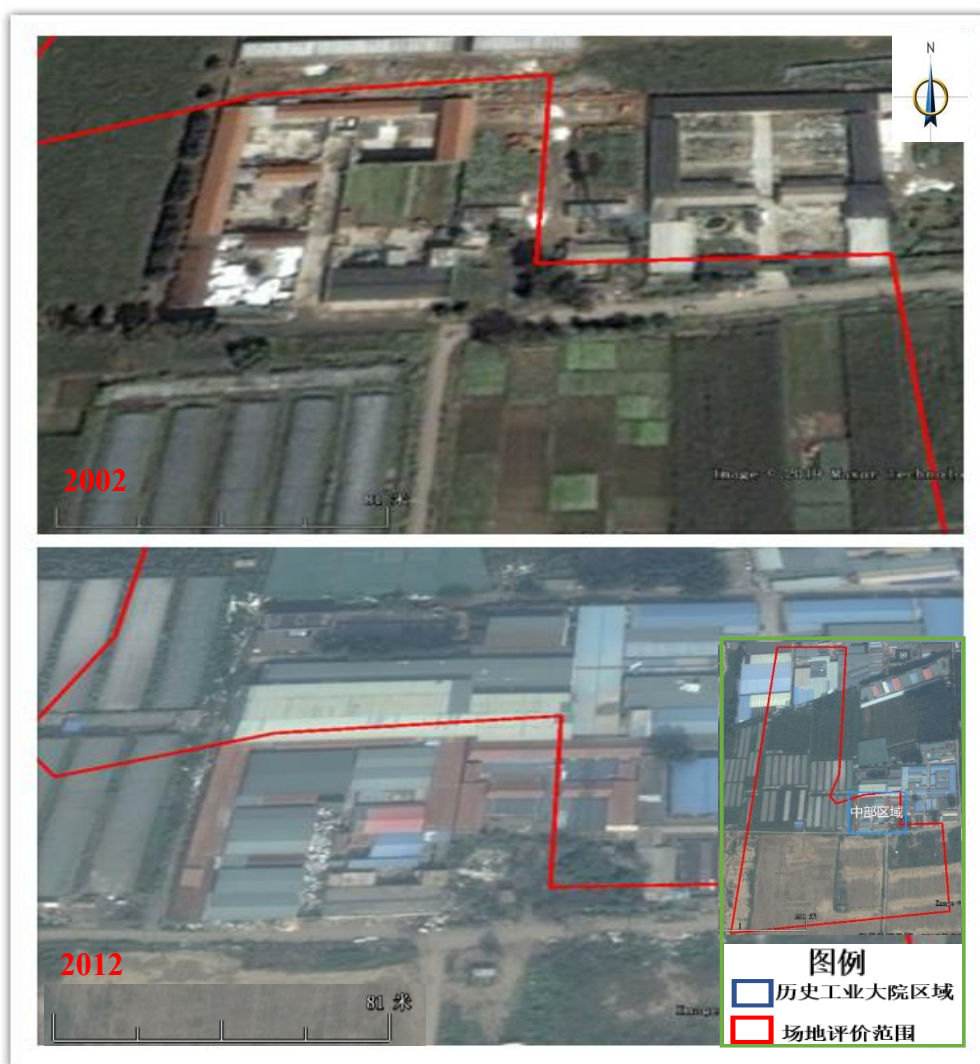
图 2.2-4 地块中部工业大院使用情况
