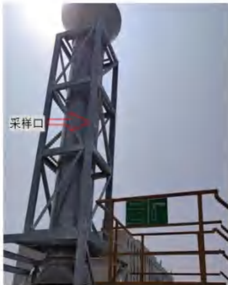
G27 中心化验室废气 2#（采样平台、采样口、标识牌）—DA003
