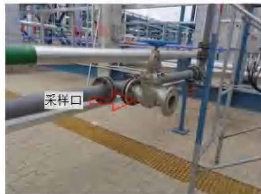
G10 氯化镁加工装置尾气排放口、采样口及标识 —DA013
