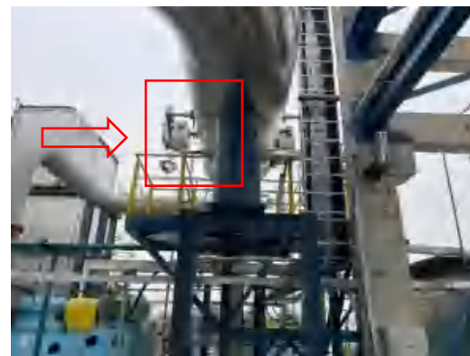
银催化剂焙烧废气 G3（DA001）过程在线监控
