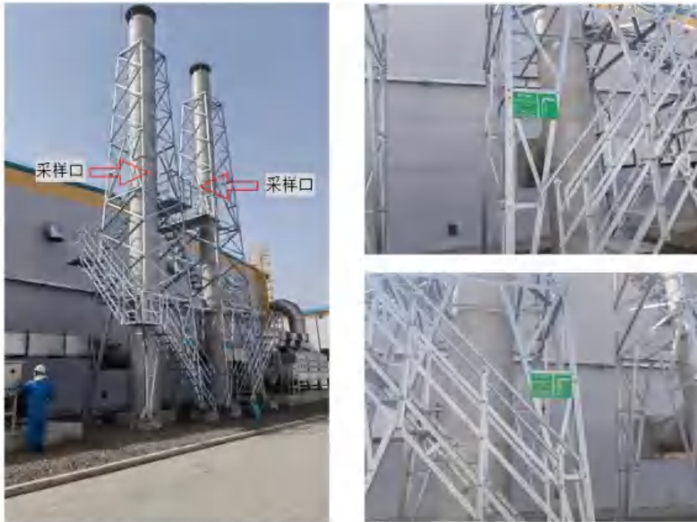
G24-25 危废间废气排放口 1-2#（采样平台、采样口、标识）—DA010、DA009
