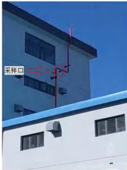
G10 氯化镁加工装置尾气排放口、采样口及标识 —DA013
