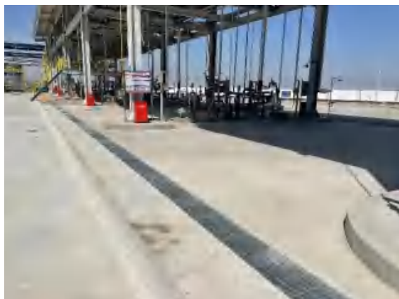
汽车栈台围堰、导水沟
