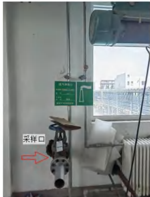
G10 氯化镁加工装置尾气排放口、采样口及标识 —DA013
