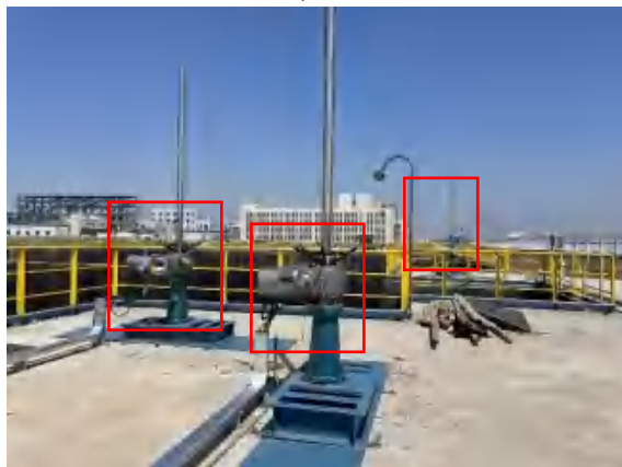
雨水监控池分区及事故水分区及阀门*3（手动+电动）
