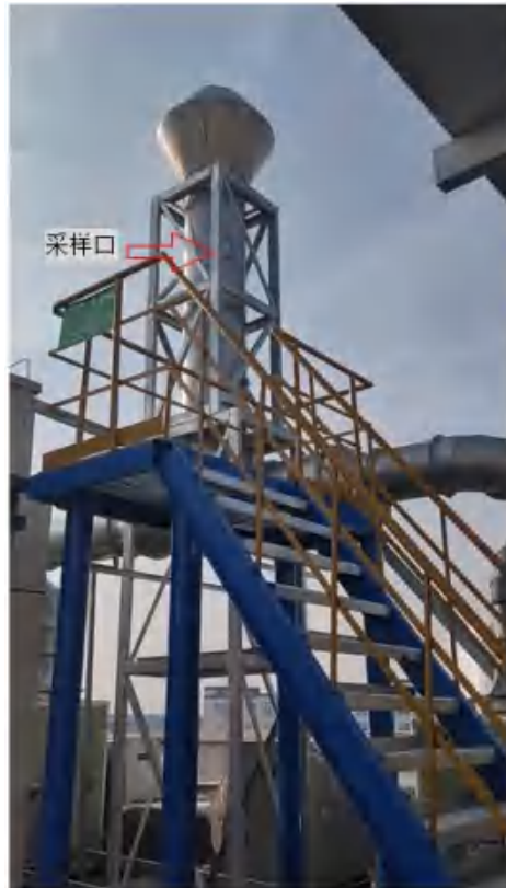
G27 中心化验室废气 2#（采样平台、采样口、标识牌）—DA003
