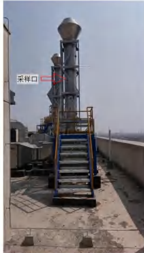
G27 中心化验室废气 2#（采样平台、采样口、标识牌）—DA003
