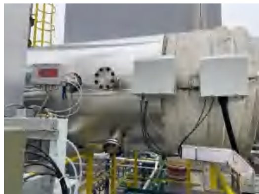
银催化剂焙烧废气 G3（DA001）过程在线监控
